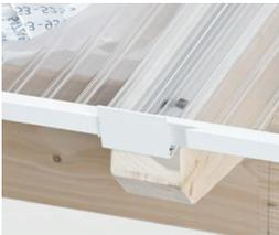
21. Die Deckel des Kompletprofil werden alle 25 cm in der mittleren Kennrinne vorgebohrt und auf die Unterprofile lose aufgelegt und mit den selbstschneidenden Schrauben 5,5 x 85 mm mit dem Unterprofil und der Unterkonstruktion verschraubt. Schrauben nur „handfest“ anziehen, bis ein leichtes Quetschen der Abdichtungscheibe durch den Schraubkopf erfolgt, damit die Platten sich nachträglich noch ausdehnen können!
