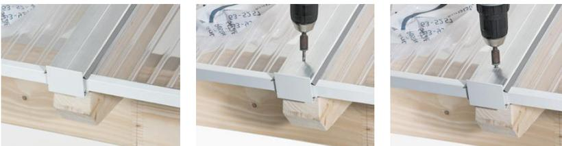
22. Die Klemmdeckel werden auf die Profile geklickt (bei Schwergängigkeit kann man mit einem Hammer nachhelfen, sollte dabei aber immer ein Schlagholz zwischenlegen). Die Randprofile erhalten auf die gleiche Art den Klemmdeckel mit Wetterschenkel, welcher aber am oberen Ende so angeschragt werden muss, dass er an der Wand anliegt.
